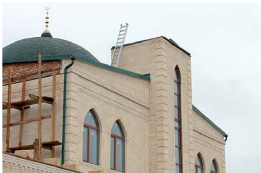
Демонтаж минарета Пятигорской мечети
